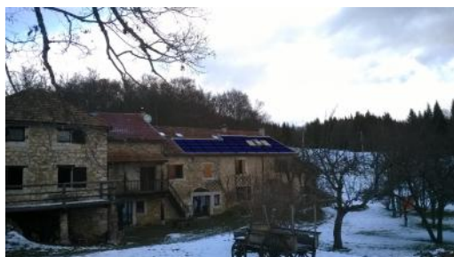
Toiture de la famille Bonnel à Saint Agnan
