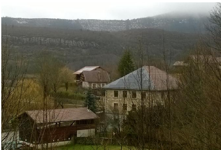
Le toit de la Communauté de Communes avec les 18 kWc du Gîte La Famiglia en arrière plan
