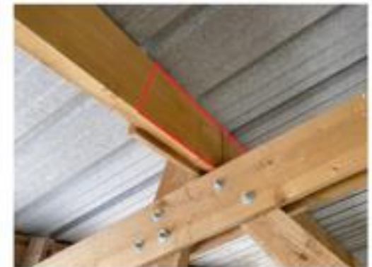
Renfort de la section d'une panne
