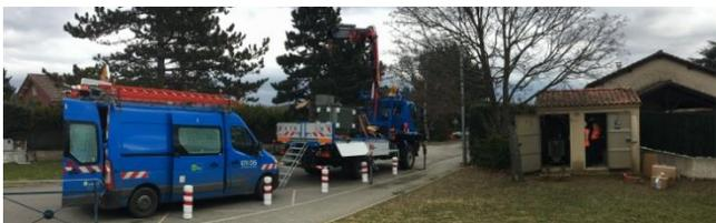
L'installation du transformateur régleur en charge a été réalisée avec succès le 08 février 2017 dans le village des Haies. Il peut maintenant participer aux expérimentations effectuées dans le cadre du projet SMAP.
